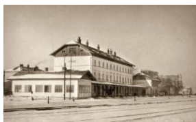
Dworzec kolejowy w Stróżach (Złoty M. Kalisza)
