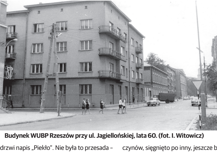
Budynek WUBP Rzeszów przy ul. Jagiellońskiej, lata 60. (fot. I. Witowicz)
